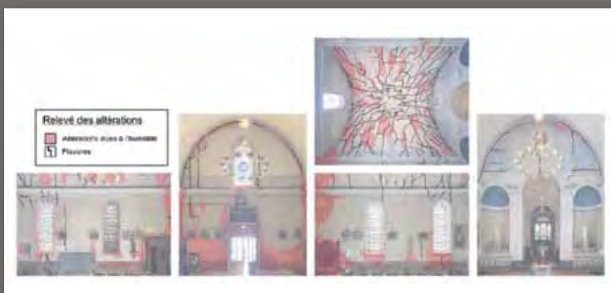
Recensement des fissures et dégâts aux décors intérieurs (Extrait du dossier de Caroline SNYERS)
